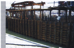
图14 整体钢性模板浇筑水下混凝土
