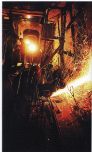
正在进行廊道内部施工 艺人 摄
