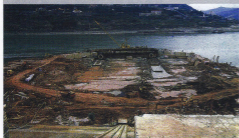
图15 围堰合拢后的施工现场
