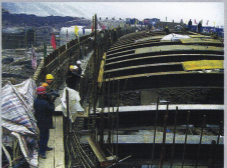
图18 弯顶钢骨架安装
