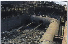
图17 参观廊道安装在导洞腔体内
