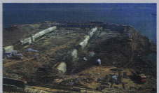
图19 上下游水平交通廊道施工
